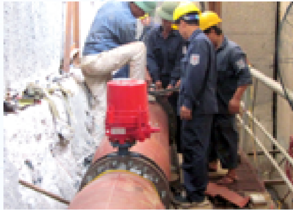
Nhân viên TTDVKT sửa chữa hệ thống van cân bằng
