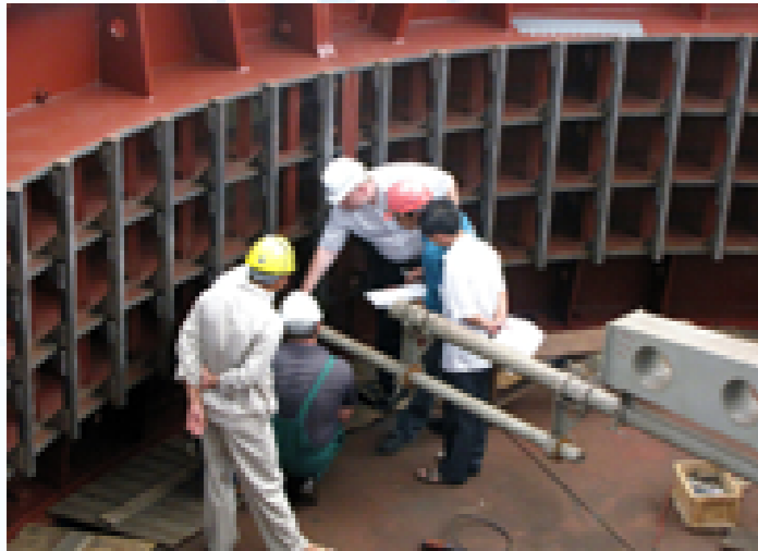
Cán bộ kỹ thuật giám sát lắp đặt máy phát
