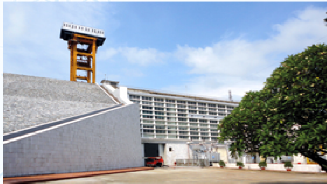
Đập chính và gian máy sau khi được cải tạo
