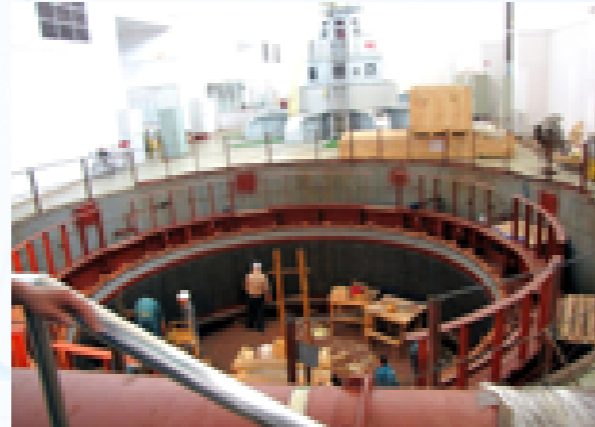
Lắp đặt máy phát điện 40MW
